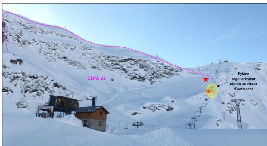
**Vue de l'aval des pentes menaçant principalement la ligne du TS Chardonnet (CLPA22 et points PIDA M43 et 44 en étoiles rouges) Fond : [www.remonteesmecaniques.net](http://www.remonteesmecaniques.net) (Source : Engineerisk, août 2022)**
