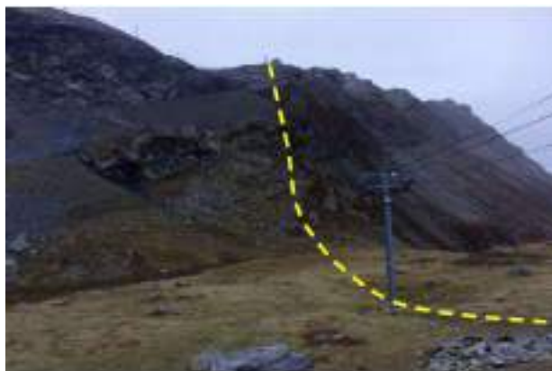
Cheminement de la ligne du TSD sur la zone 2 aval
