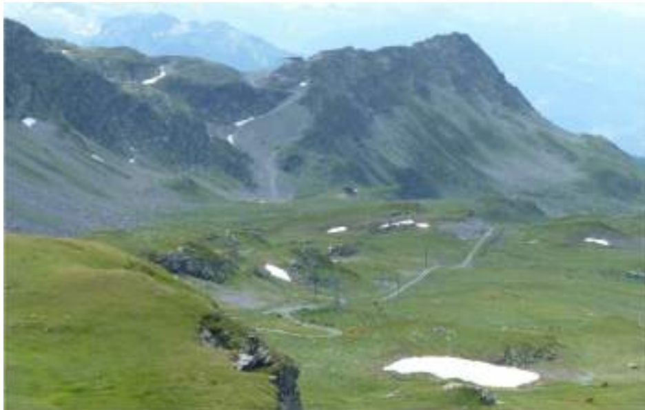
Insertion paysagère du télésiège en vue éloignée zoomée (depuis la combe de Bellecombe)
