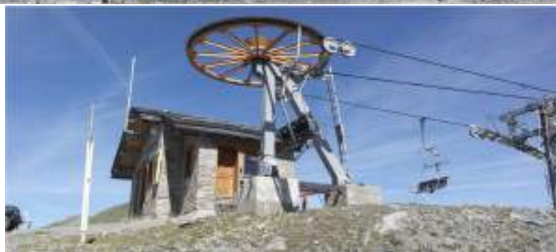
Le col de la Traversette et la gare amont du TS Chardonnet
