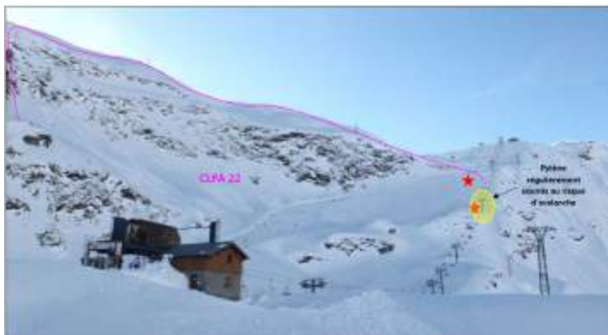
Vue de l'aval des pentes menaçant principalement la ligne du TS Chardonnet (CLPA22 et points PIDA M43 et 44 en étoiles rouges) Fond : www.remonteesmecaniques.net (Source : Engineerisk, août 2022)
