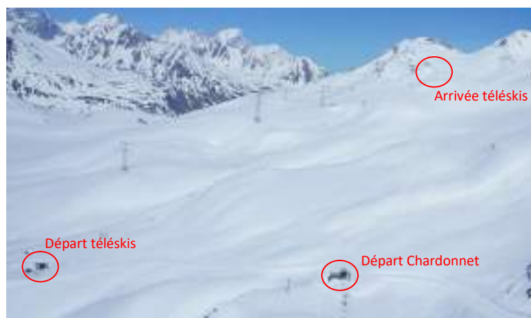
Ligne des téléskis Bellecombe 1 (Source : EPODE, 2016)
