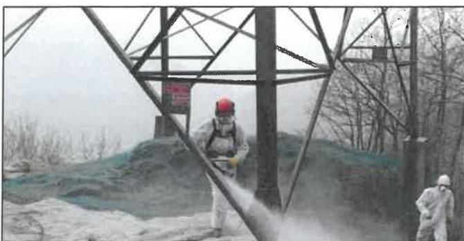
La préparation des surfaces avec l'utilisation d'un nettoyeur haute pression à eau permet le décollage des anciens fonds non adhérents. Dans les cas particuliers où l'accès à l'eau n'est pas possible, le décapage est réalisé à la main par grattage.
