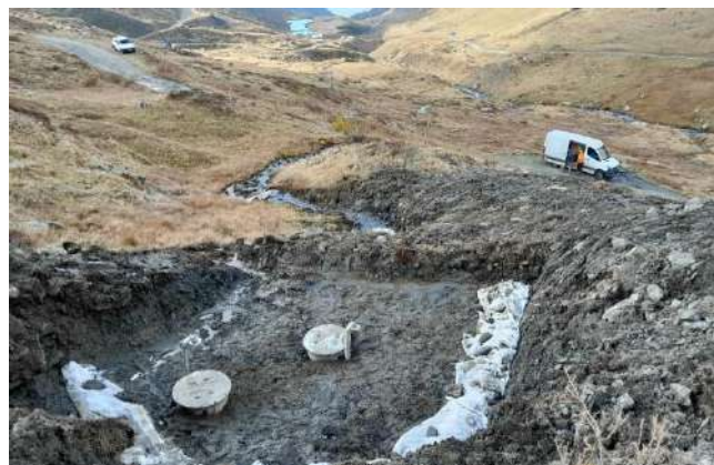
Remblaiement de la géomembrane
