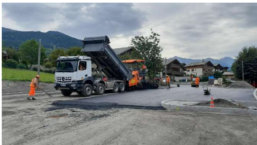
Application d'enrobé sur la voirie et les stationnements au finisseur
