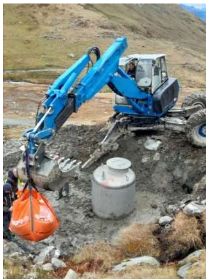
Remblaiement et drainage des eaux de surface
