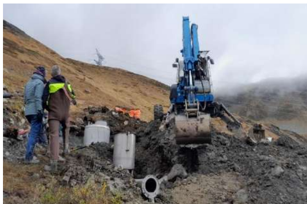
Mise en place de cloche de captage et pot de mesure
